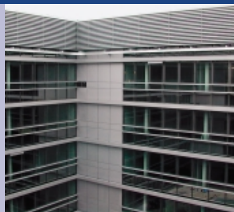
Schallschutzzaun an der Fassade im Innenhof der Commerzbank
