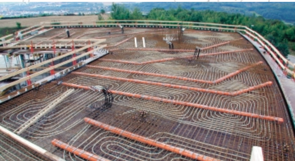
Einbringung der Lüftung und Heizung in den Betonkern: BV Passivhaus Ulm.
