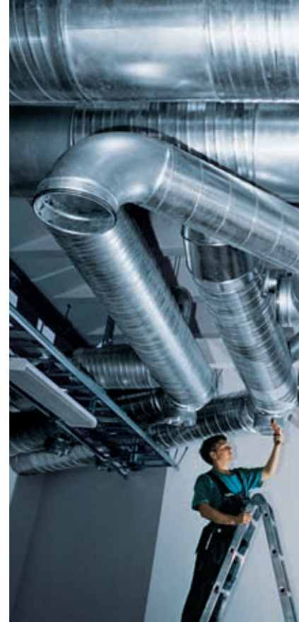
Abb. 7: Kanäle aus feuerver- zinktem Feinblech für die Lüftungs-/Klima- technik
