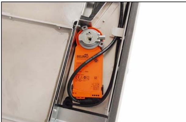
Mit dem mitgelieferten Magneten kann der Motor entriegelt und die Klappe von Hand verstellt werden.
