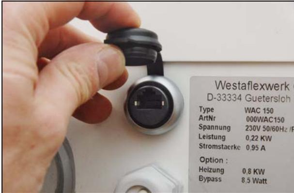
Das Gerät kann über einen PC betrieben werden. Für den Betrieb innerhalb eines Netzwerkes ist ein entsprechender Schnittstellenadapter erforderlich. Über die Schnittstelle kann das Gerät bei vorhandener Gebäudeautomation auch an die Gebäudesteuerungstechnik, angebunden werden. Für nähere Informationen an den Hersteller des Gerätes, Firma Westaflex, wenden.
